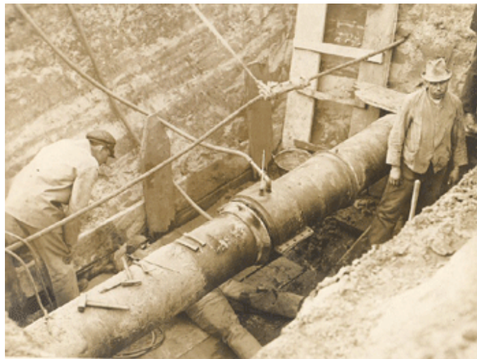
Bau einer Gasleitung 1930
